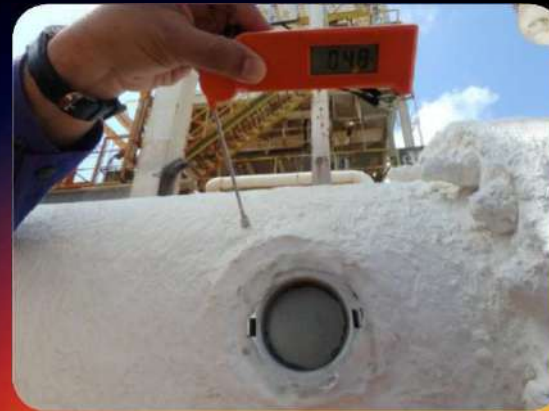
Inspektionsöffnung No. 2 – Temperatur auf Wärmedämmbeschichtung: 48°C
